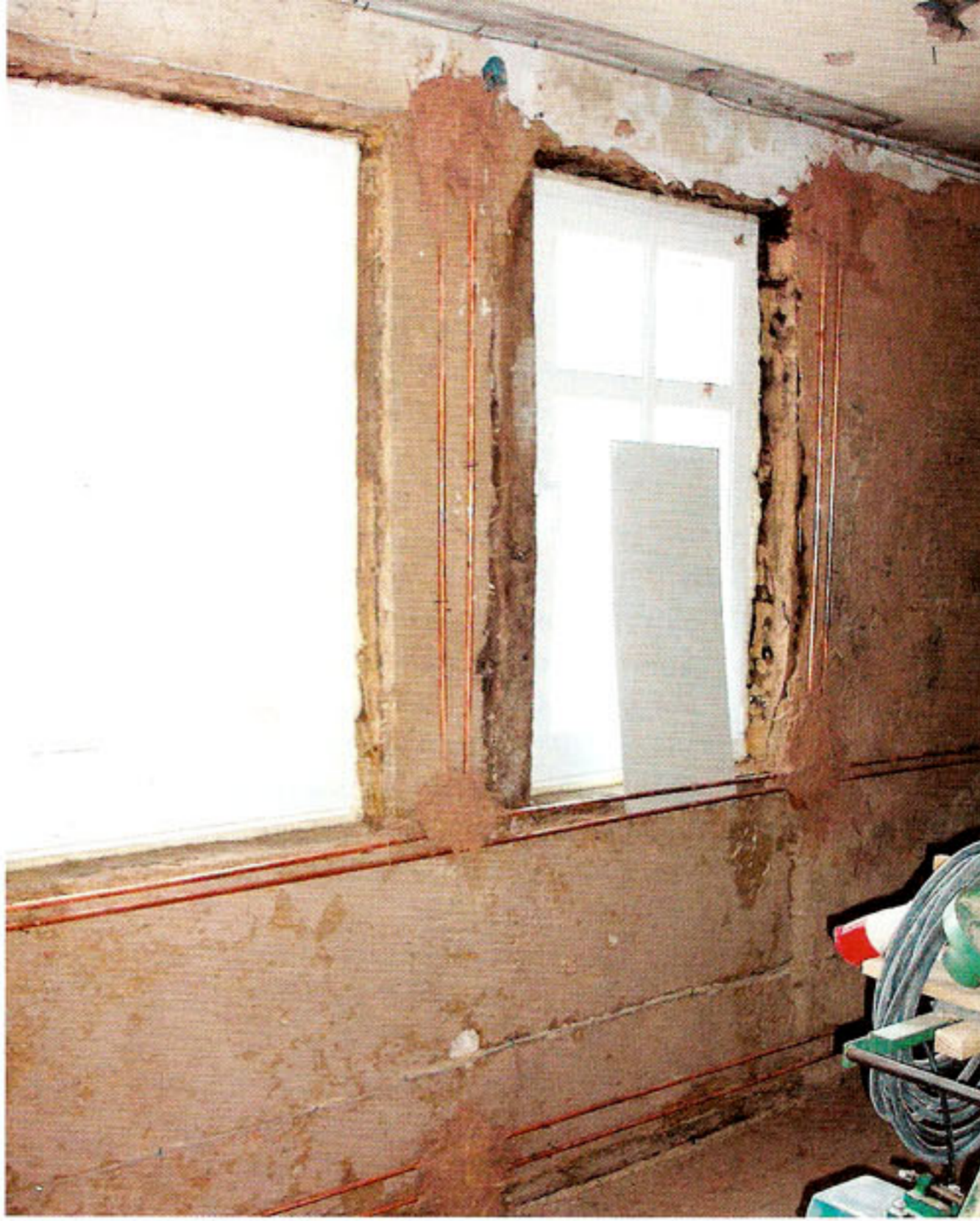
1 + 2 Dieses Fachwerkhaus in Hessen litt unter aufsteigender Feuchtigkeit. Dank der Wandtemperierung ist es wieder bewohnbar. An den Außenwänden wurden die Heizschleifen oberhalb der Sockelleisten verlegt und um die Fenster- und Türleibungen herumgeführt. Anschließend trugen die Handwerker den Lehmputz auf.
